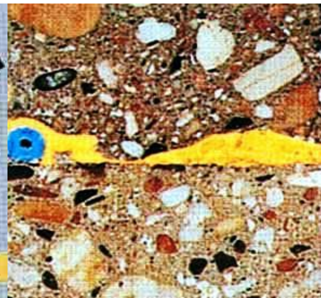
ЗАПОЛНЕНИЕ ШВА В НЕПРОФОРМОВАННОМ БЕТОНЕ
