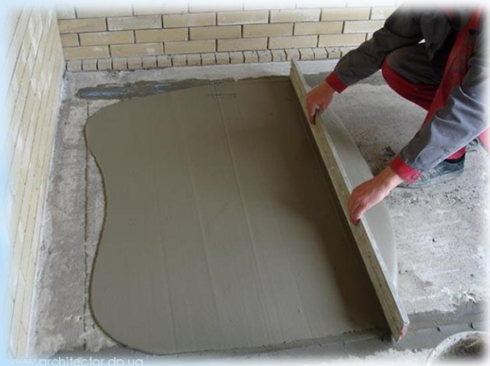
выравнивание стяжка (основание для укладки чистового пола)
