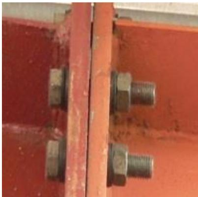
— скрепление двух и более деталей при помощи болта, гайки и шайбы. Скрепляемые детали имеют гладкие (без резьбы) сквозные соосные цилиндрические отверстия, диаметр которых в 1,1 раза больше диаметра болта.
