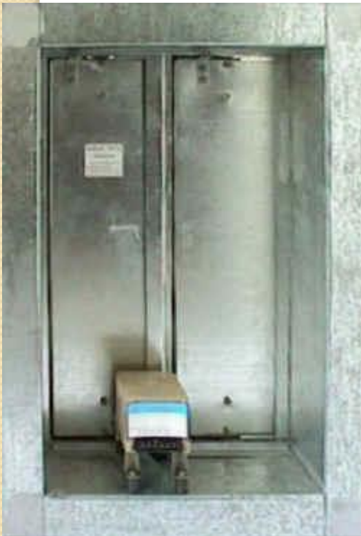
Клапан дымовой КВП-Д канальный Предел огнестойкости E120.
