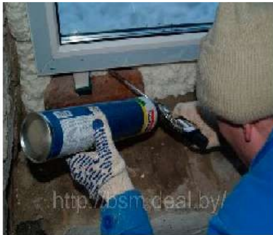
Заполнение стыка монтажной пеной
