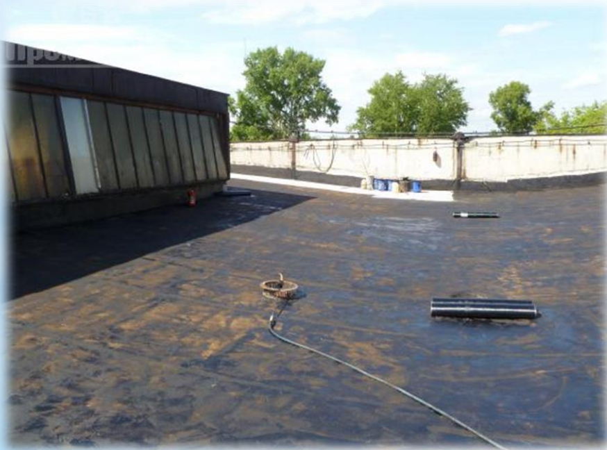
Огрунтовка битумом
