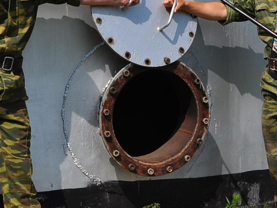
• Замерные люки открываются при измерениях уровня налива горючего и отбора проб, в остальное время они содержатся закрытыми с прокладками и опечатанными или опломбированными
