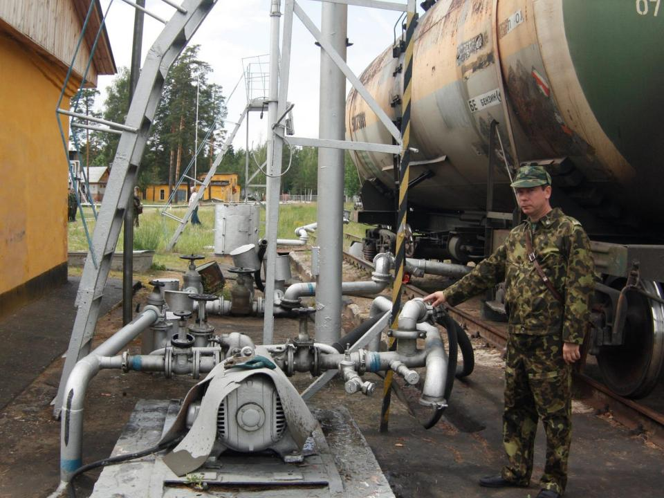
Проверка герметичности сливно-наливных устройств (без рукавов) производится один раз в два года путем гидравлической или пневматической опресовки.
